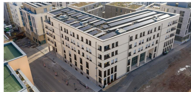
SWSG-Wohnhaus Breitscheidstr. 111 58 kWp Baujahr 2019 (Kooperation SWS) Bild: Jakob Marwein
