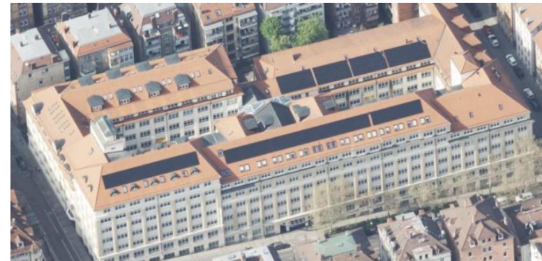
Stuttgarter Versicherung Rotebühlstr. 120 89 kWp Baujahr 2020 (Kulturdenkmal)
